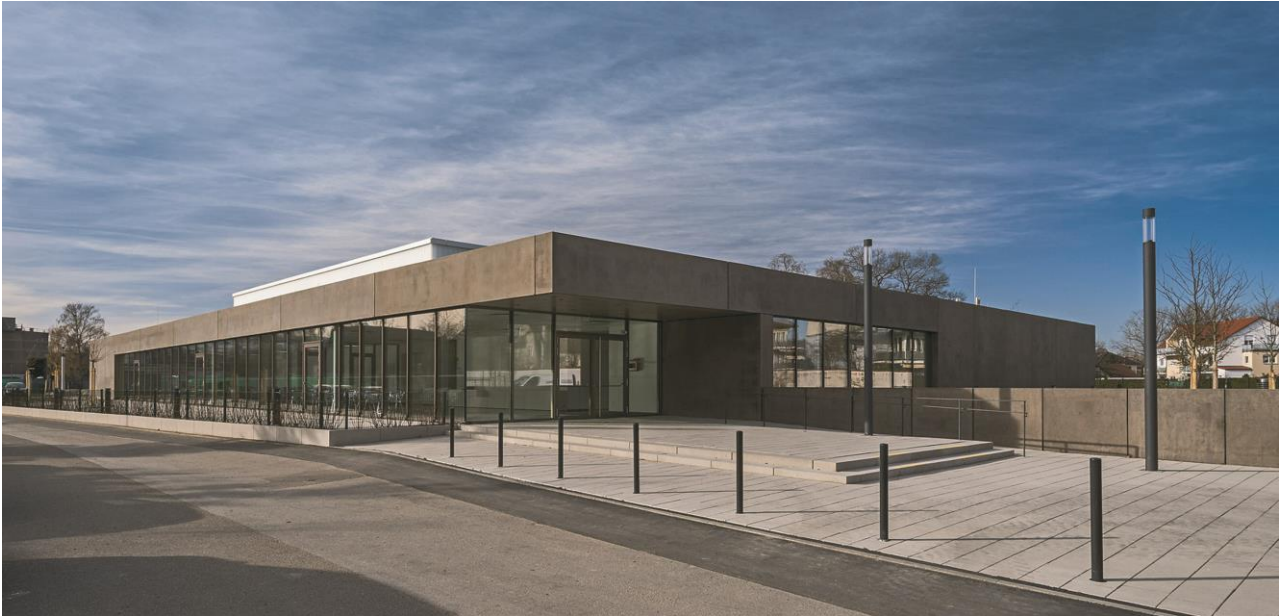
© Foto Eckhart Matthäus | Eberle Architekten
